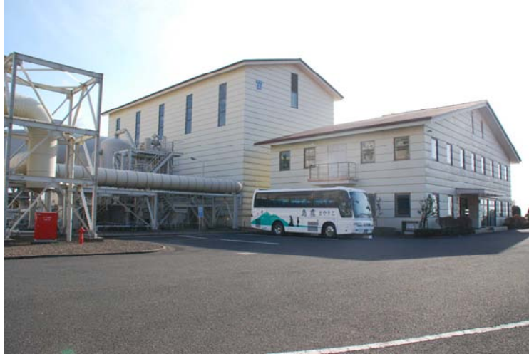
大霧地熱発電所の建屋
