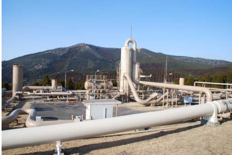
大霧地熱発電所の生産井基地
