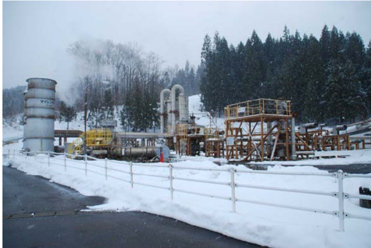
柳津西山地熱発電所の生産井基地（P1）
