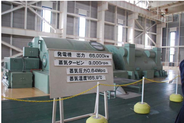
柳津西山地熱発電所のタービンと発電機
