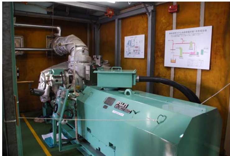
霧島国際ホテル地熱発電施設のタービンと発電機
