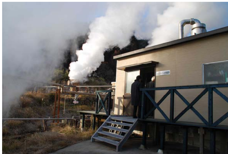
霧島国際ホテルの自家用地熱発電施設建屋
