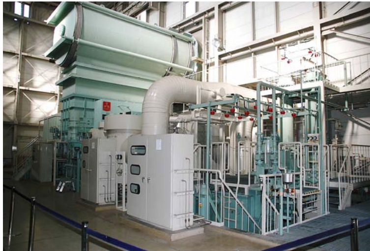
大霧地熱発電所のタービンと発電機
