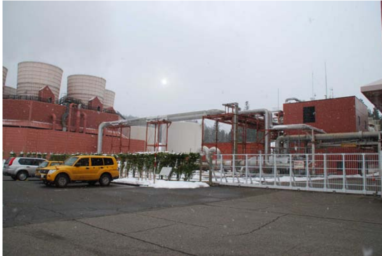
柳津西山地熱発電所の建屋とクーリングタワー
