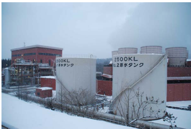
柳津西山地熱発電所の施設
