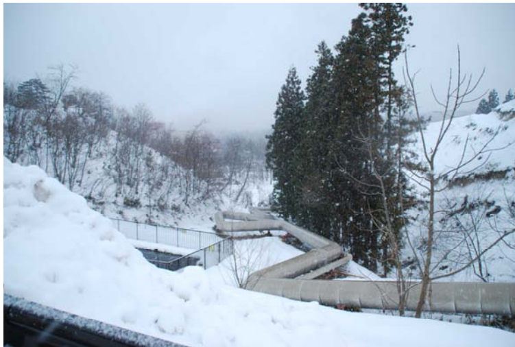
森林を伐採して敷設された配管
