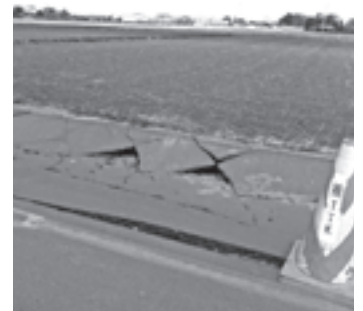
地震により道路が深く陥没している 宮城県仙台市
