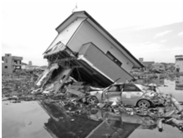
震災による、地盤沈下によって水が溜まり、沼のようになっている。
