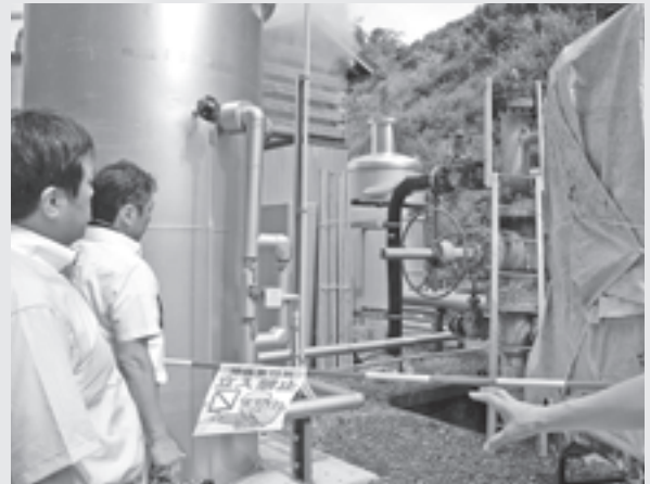
発電実証試験設備は屋内と屋外に分かれている。写真上は屋外の温泉の井戸(深さは1300メートル、温泉は97℃の高温)、冷却塔、変電設備などがある
