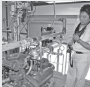
屋内には熱源ポンプ、アンモニアポンプ、蒸発器、再生器、気液分離器、タービン発電機などが置かれている
