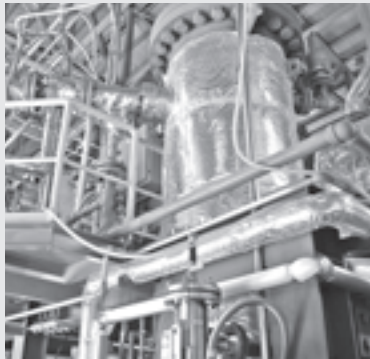
屋内には熱源ポンプ、アンモニアポンプ、蒸発器、再生器、気液分離器、タービン発電機などが置かれている
