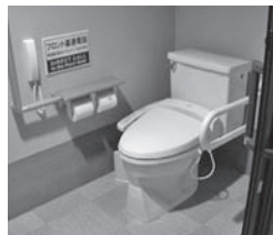
車いすでも利用できるトイレ
