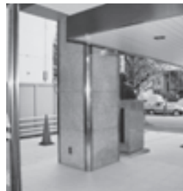
ハイパー工法で補強された全国旅館会館入口の柱
