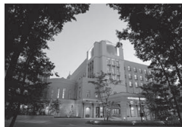
水戸プラザホテル外観
